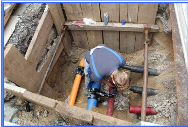
Erneuerung von Leitungen
